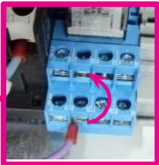
Dla elektrolizera soli: Inwersja schematu logicznego sterowania HP / H3
