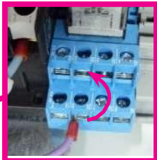
Dla elektrolizera soli: Inwersja schematu logicznego sterowania HP / H3
